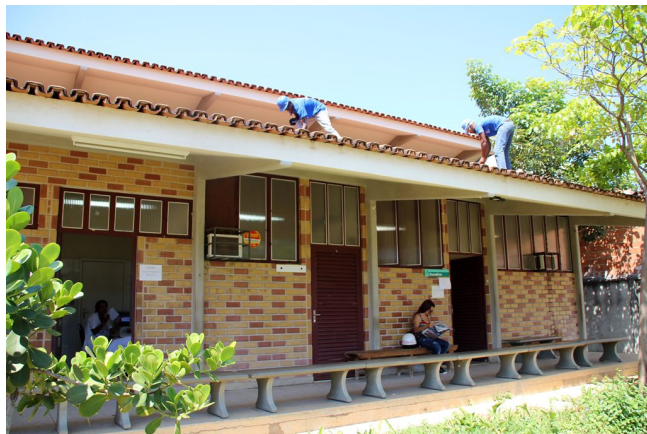
Na manhã desta terça-feira, PMI iniciou as obras de recuperação em nove Unidades Básicas de Saúde do município. Foto: Secom/PMI
